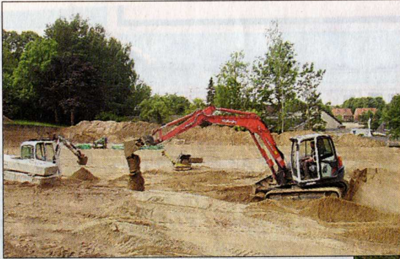
Am 6. Juli begannen die Arbeiten für die neue Reinfelder Sporthalle an der MCS. Der neue Standort ist bereits hergerichtet. Fotos: NURSEY
